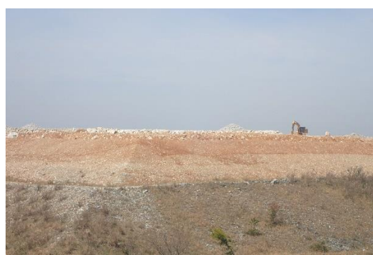
大きな重機で作業中 12時09分
