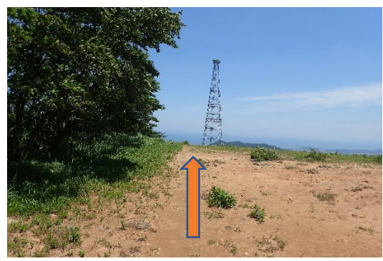
無線中継所の鉄塔が現れた 12時22分
